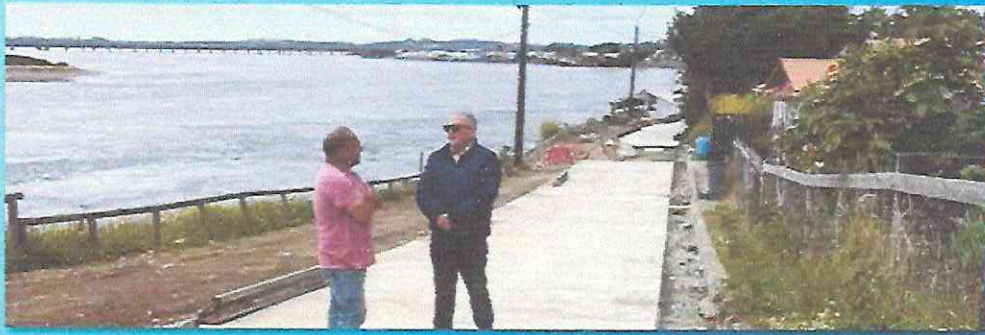
Pavimentación Pasaje A.Latorre, Pudeto Medio, Cruz del Sur.
